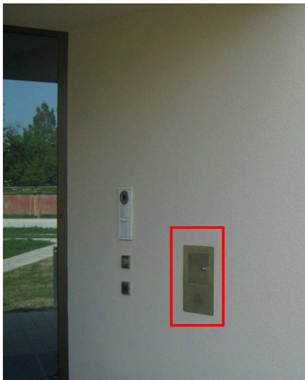
Bild 19: FSD Typ 3 in Wand integriert
