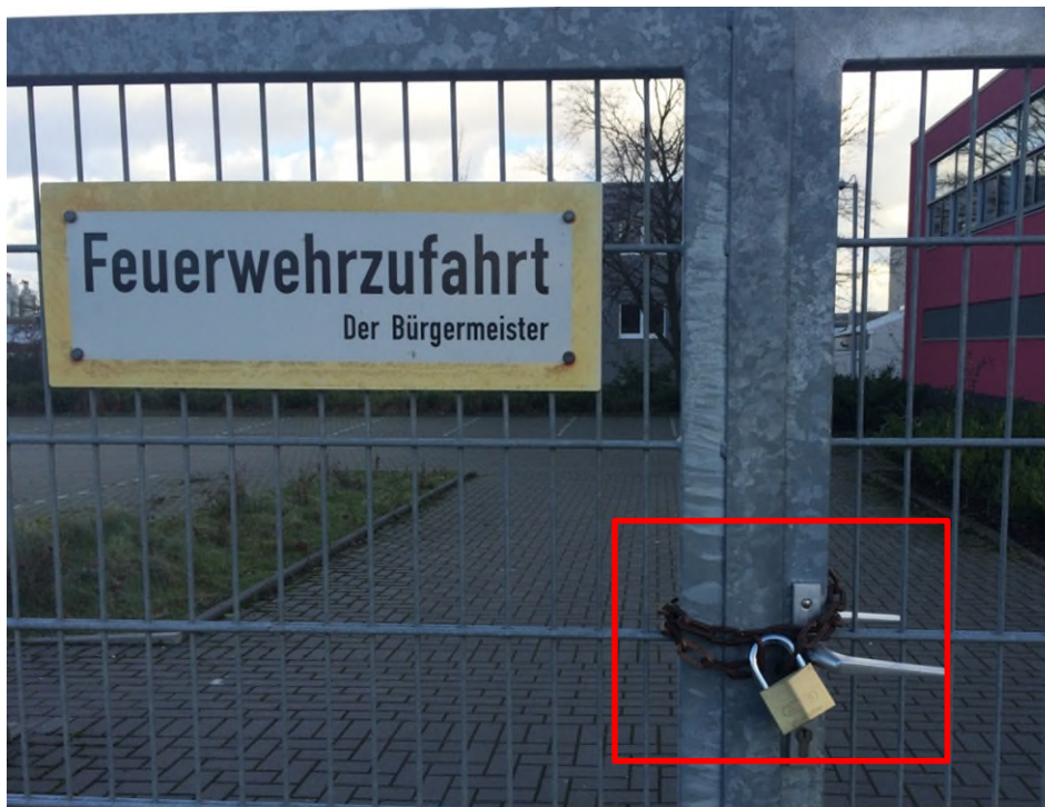
Bild 14: Feuerwehrezufahrt durch Kette mit Vorhängeschloss gesichert
