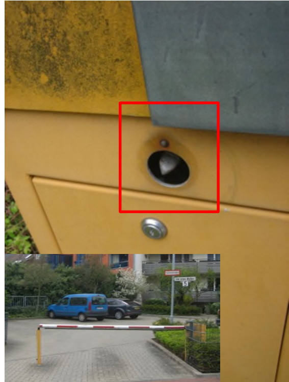
Bild 11: Dreikanteinsatz zur Öffnung einer Schranke
